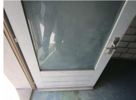
6.16 Aussetüre Keller Glas/Metall (Glas nicht durchbruchssicher)
