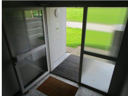
6.15 Haupteingangstüre Glas/Metall (Glas nicht durchbruchssicher)
