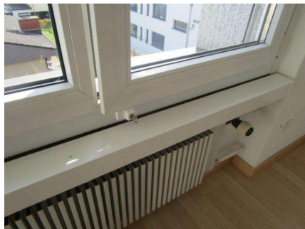
6.14 Fenster ohne Verbundsicherheitsglas (Flügel mit Schloss)
