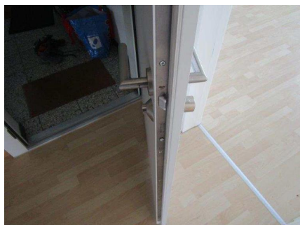
6.31 Abschlusstüren Wohnungen (2020 ersetzt)
