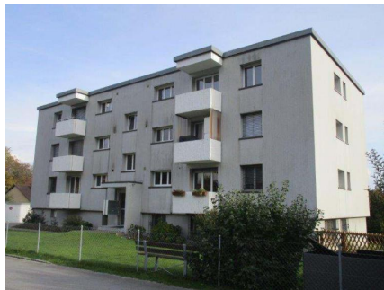
6.4 Nord- u. Westfassade
