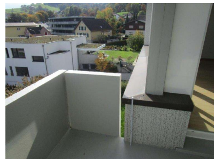
6.11 Fensterbrüstung Südbalkone mit 60cm Höhe begehbar
